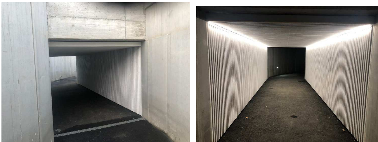
Le tunnel ferroviaire réalisé avec un revêtement en bois
